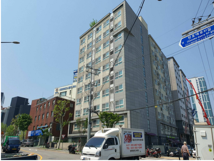
본건 건물 전경
