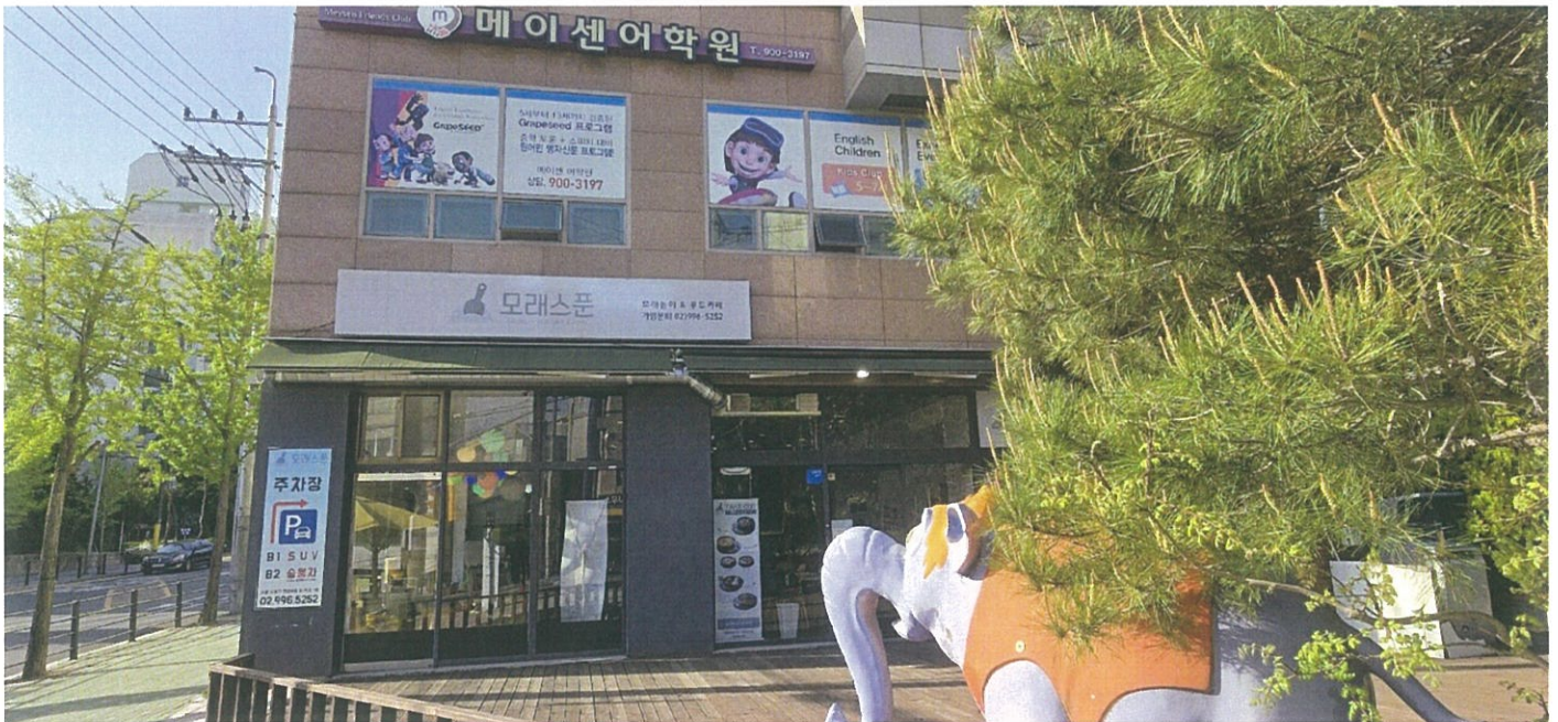
본건 제1층 제101호 주변 전경
