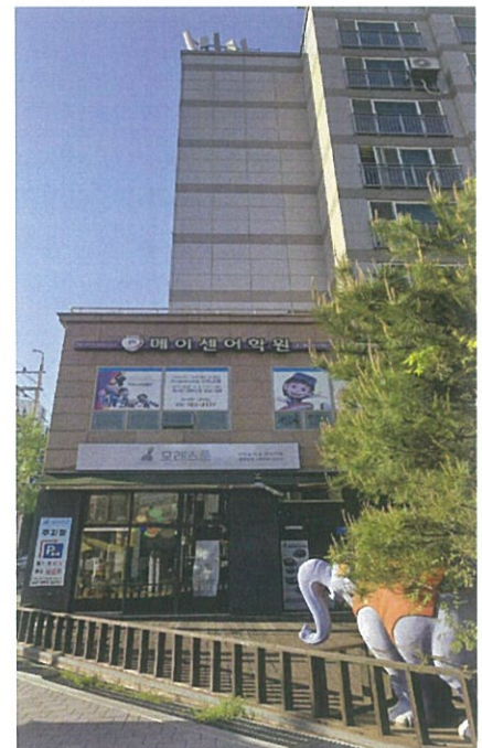
본건 제1층 제101호 주변 전경
