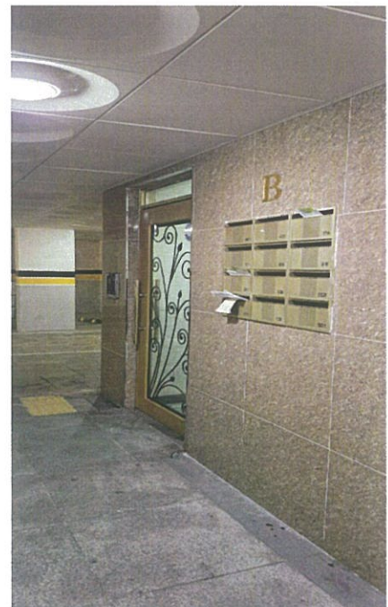
본건 제B동 입구 전경
