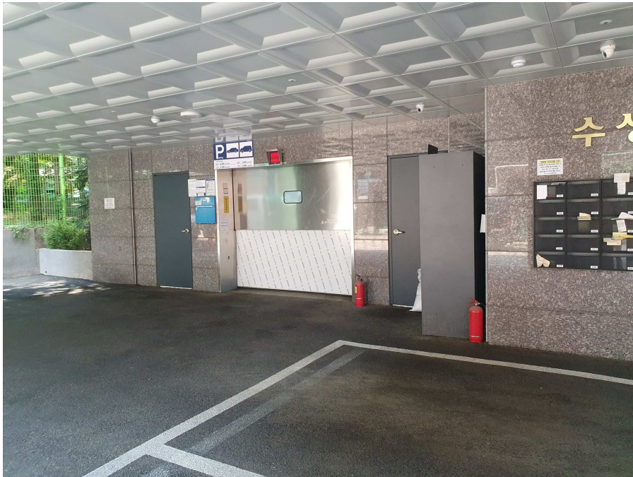
옥내 기계식 주차장 입구
