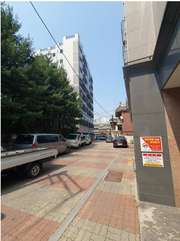
대상건물 및 남동측 도로 상황
