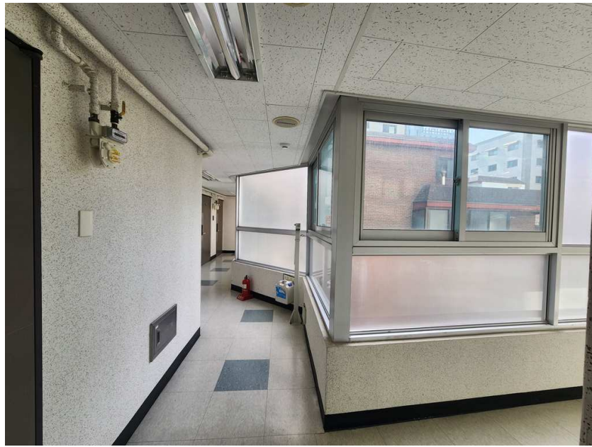
4층 복도 전경
