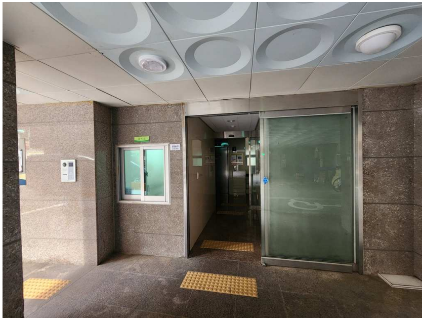
본건 1층 공동 출입문
