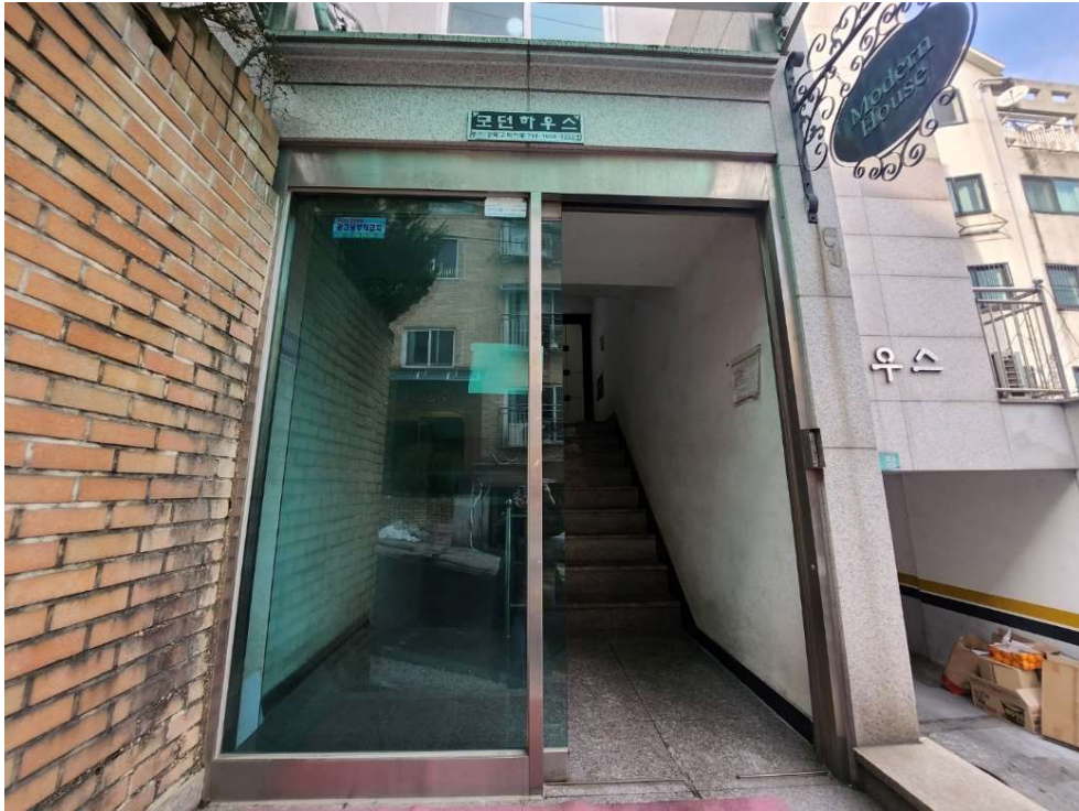
지하1층 출입구 부분
