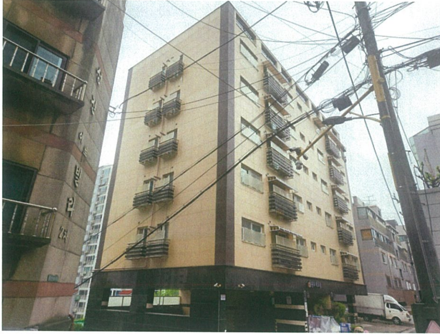
본건 전경(남동측에서 촬영)
