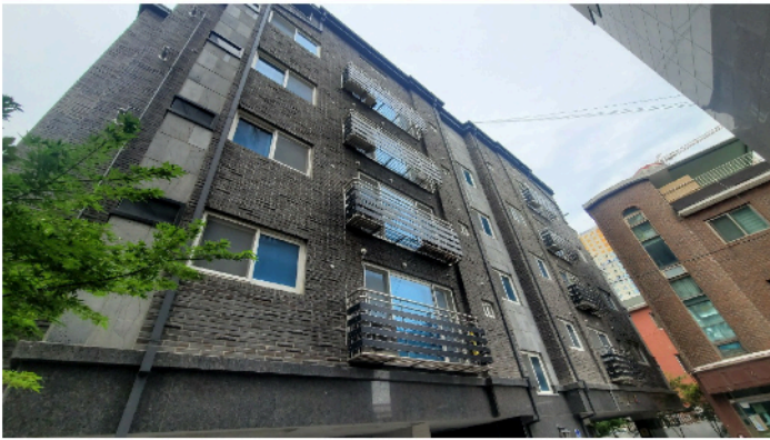
본건 전경(남동측에서 촬영)
