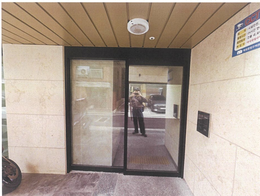
본건 소재 건물 공동출입구
