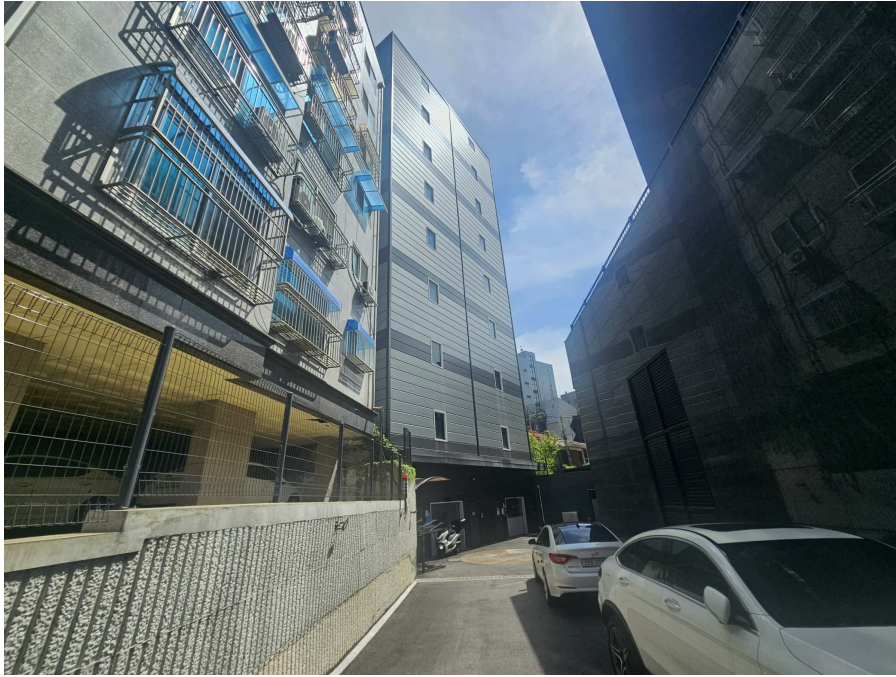
[ 기계식 주차장 전경 ]
