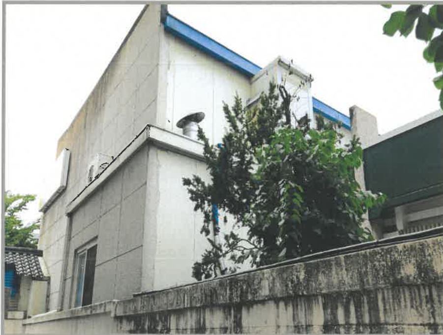
【 본건 기호(2) 및 제시외건물(ㄱ)전경 】
