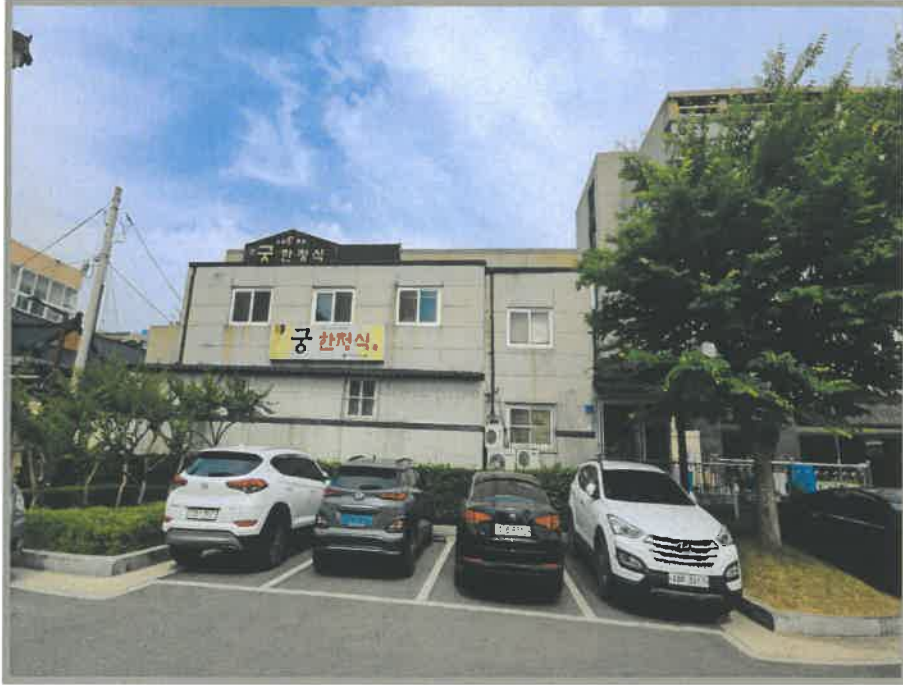
【 본건 기호(2) 및 제시외건물(ㄱ)전경 】
