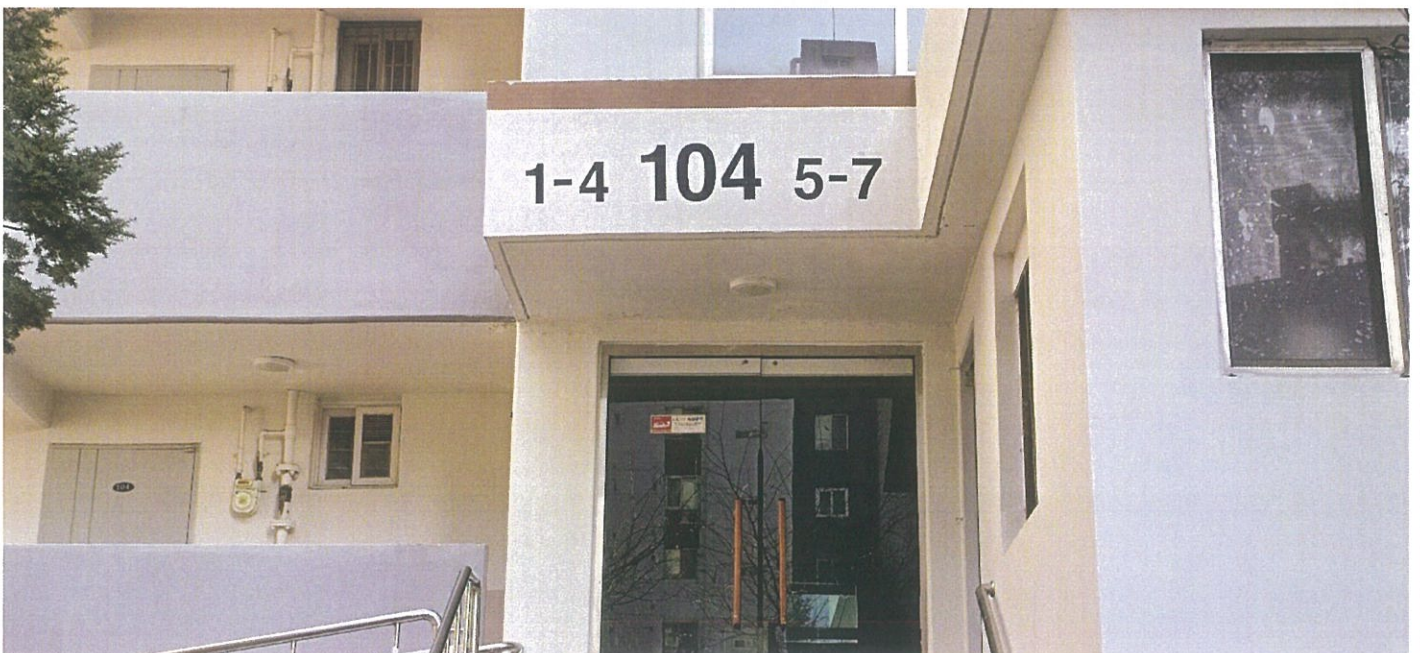
본건 동부아파트 제104동 입구 전경
