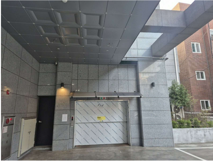
< 기계식 주차설비 전경 >
