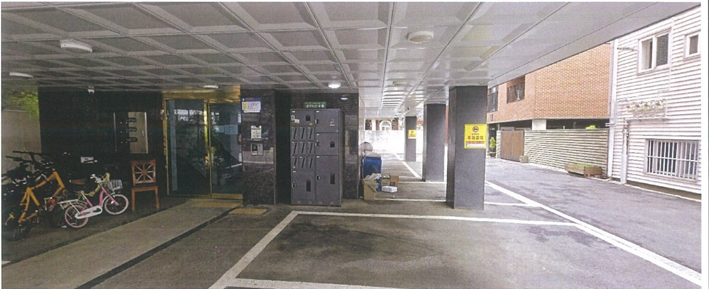
본건 주차장 시설 전경
