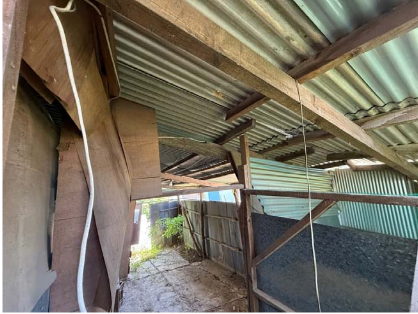
[ 제시외건물(ㄷ) 내부 전경 ]
