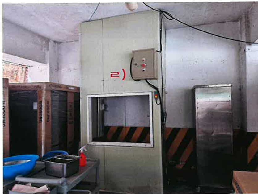
[ 제시외건물 ㄹ) 전경 ]
