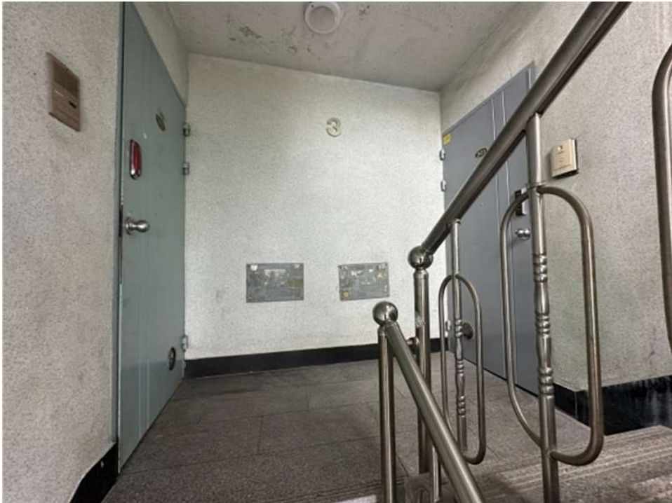
본건 건물 3층 복도 전경
