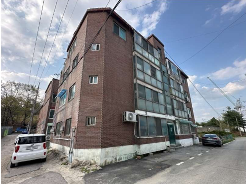
본건 건물 전경
