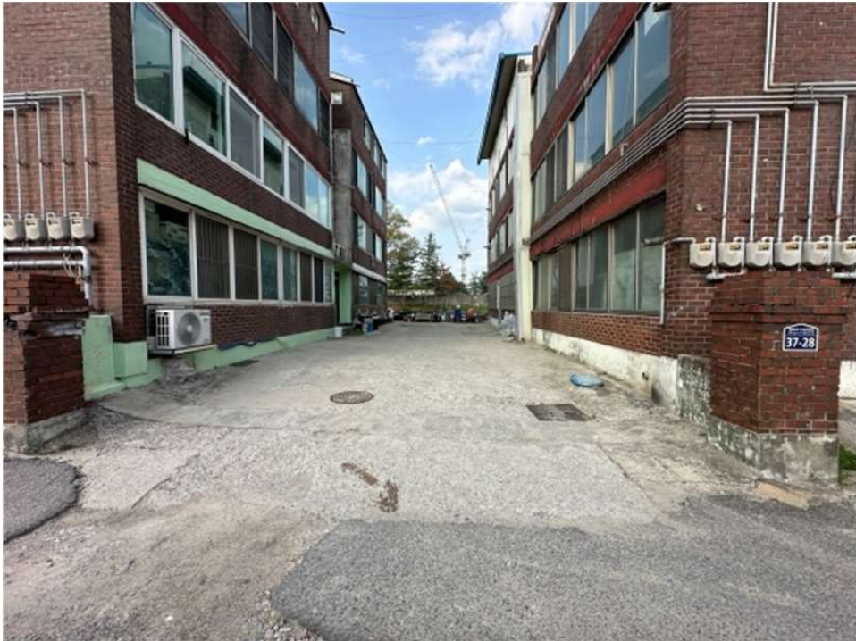
본건 단지내 지상 주차장 전경
