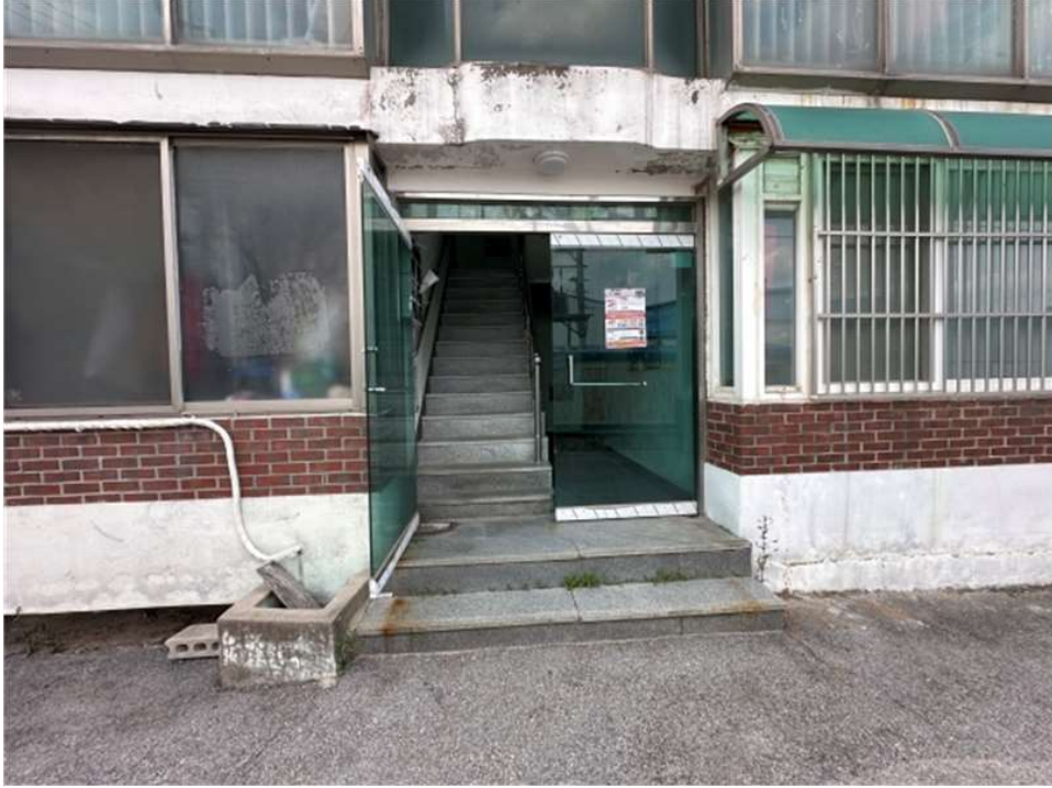
본건 건물 1층 출입구 전경
