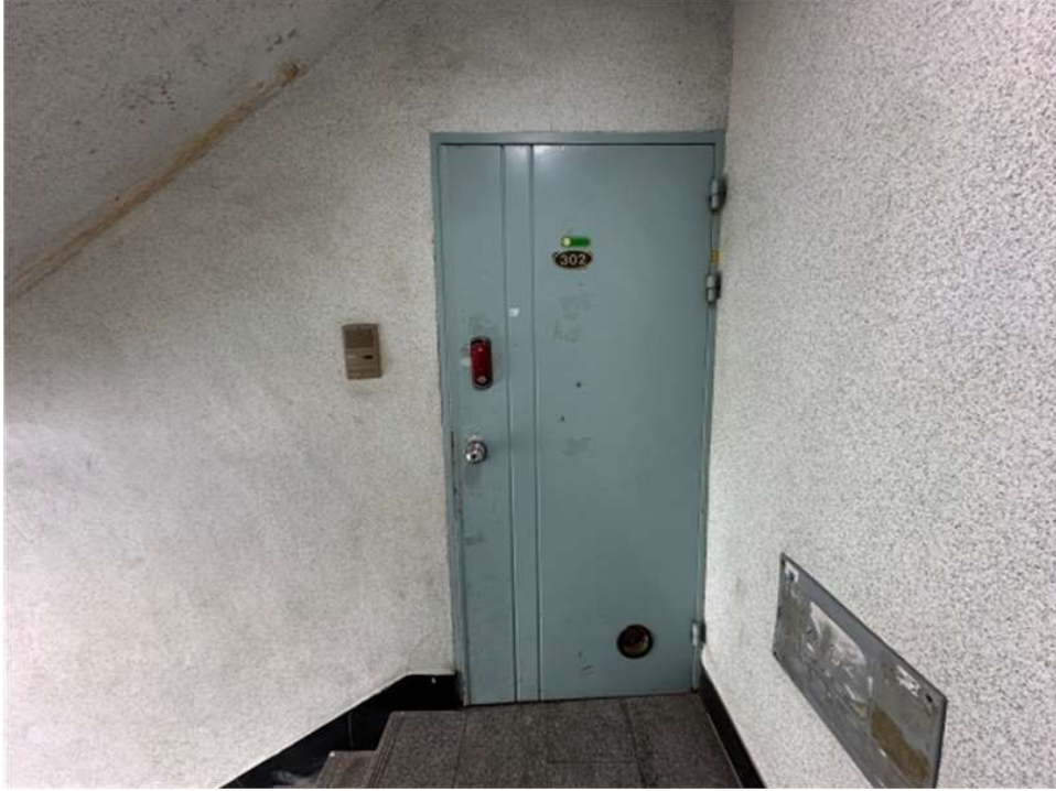
본건 출입문(302호) 전경
