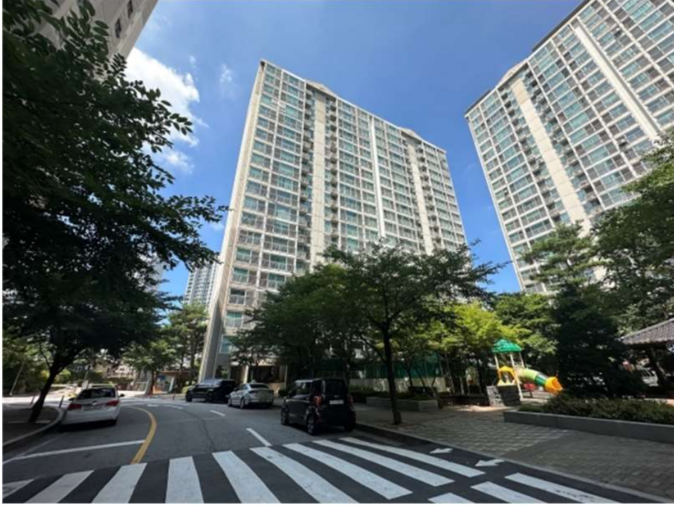
본건 건물(104동) 전경
