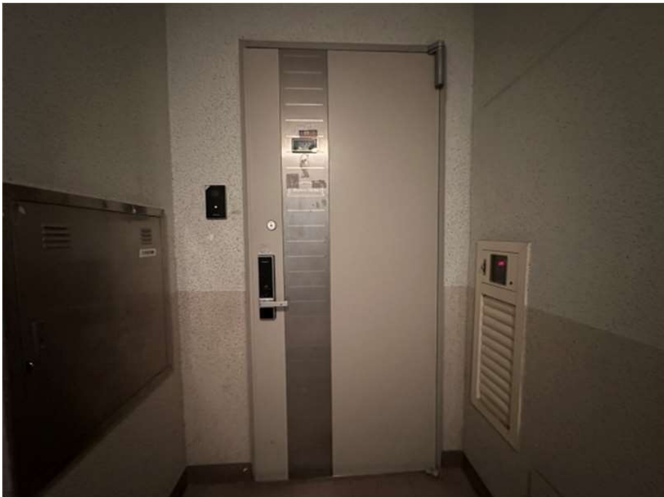
본건 출입문(302호) 전경
