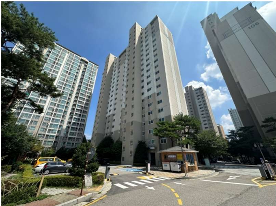
본건 건물(104동) 전경
