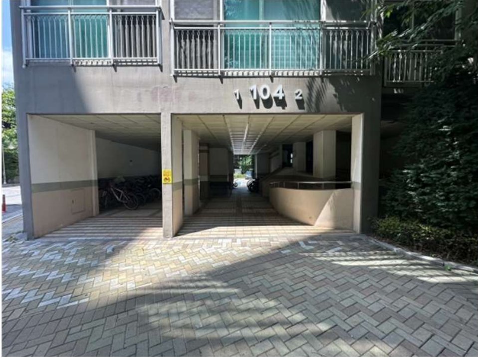
본건 건물(104동) 1층 전경
