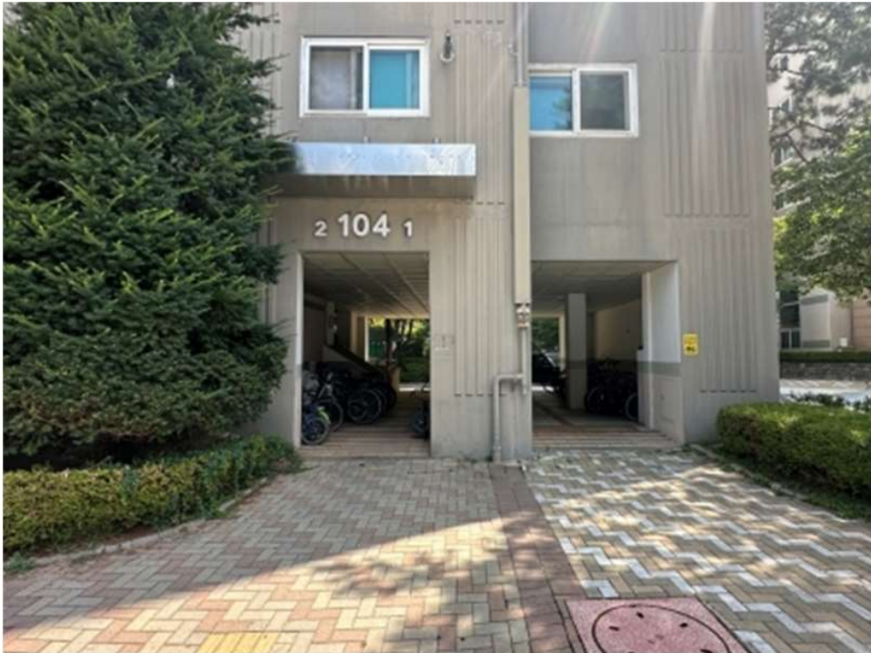
본건 건물(104동) 1층 전경
