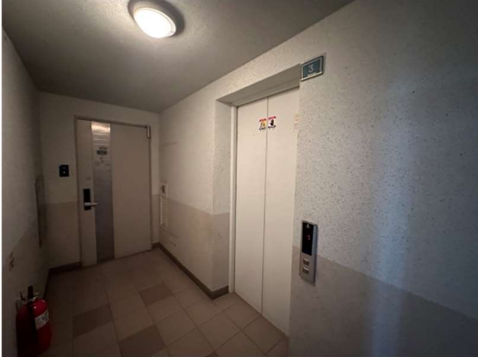
본건 건물(104동) 1,2호 라인 3층 복도 전경
