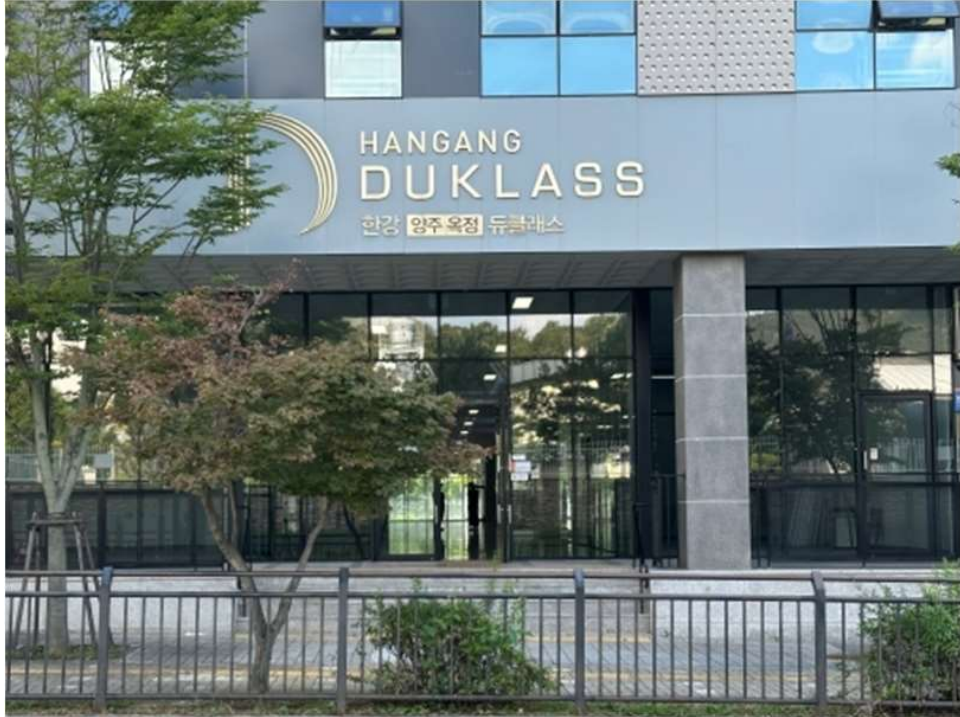
본건 건물 1층 출입구 전경
