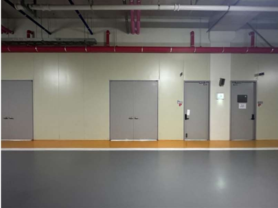
본건 건물 4층 복도 전경
