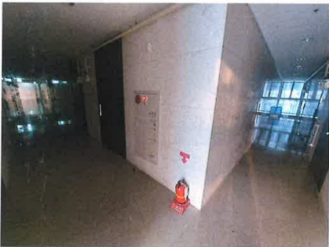
본건 복도 전경
