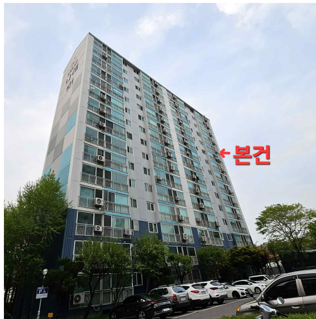
본건 전경 (남서측 촬영)
