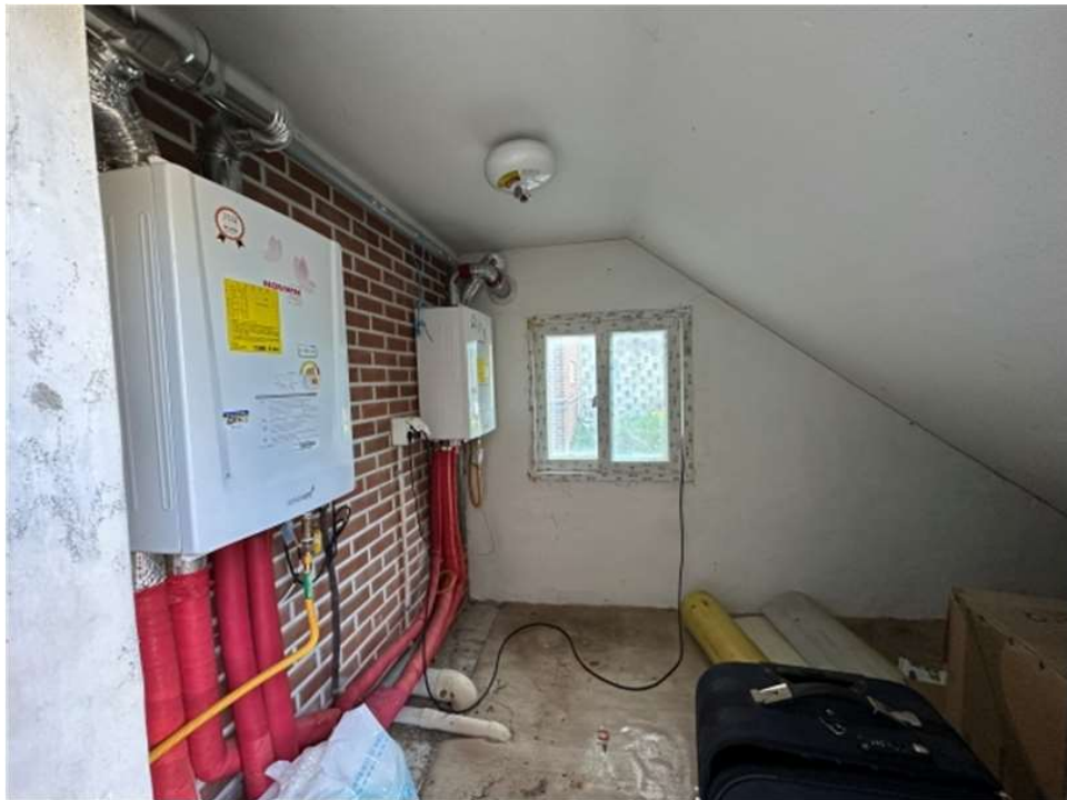
본건 건물 지층 보일러실 내부 전경
