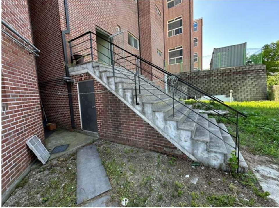
본건 건물 지층 계단실 및 보일러실 전경
