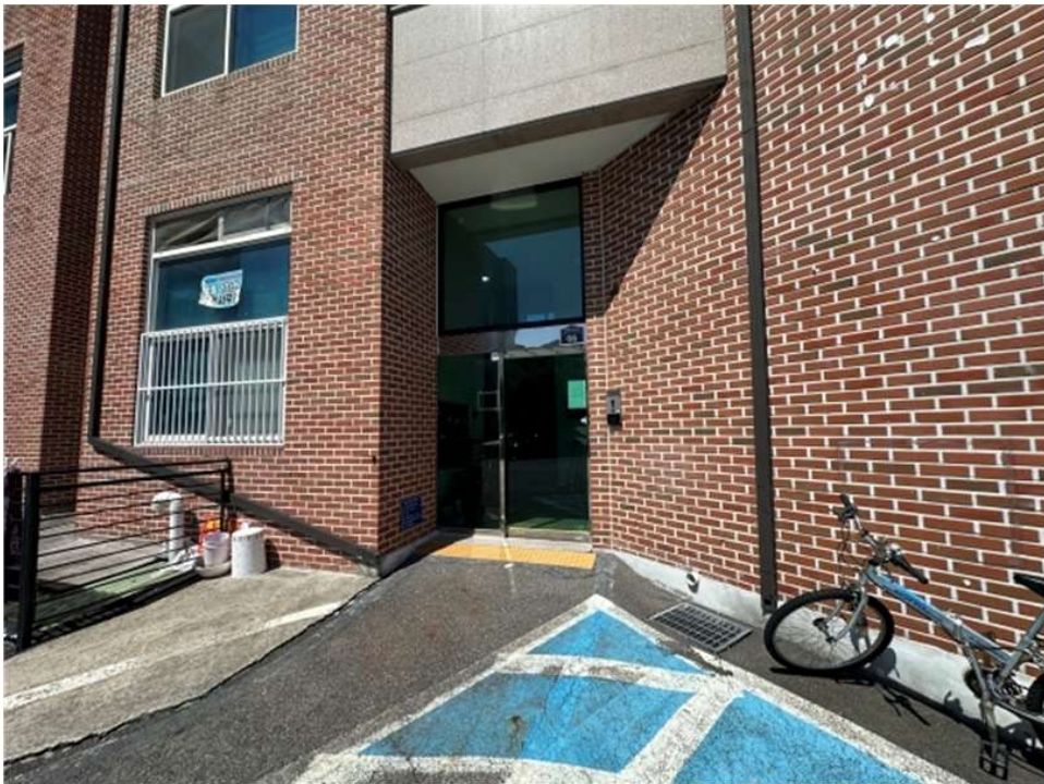
본건 건물 1층 출입구 전경
