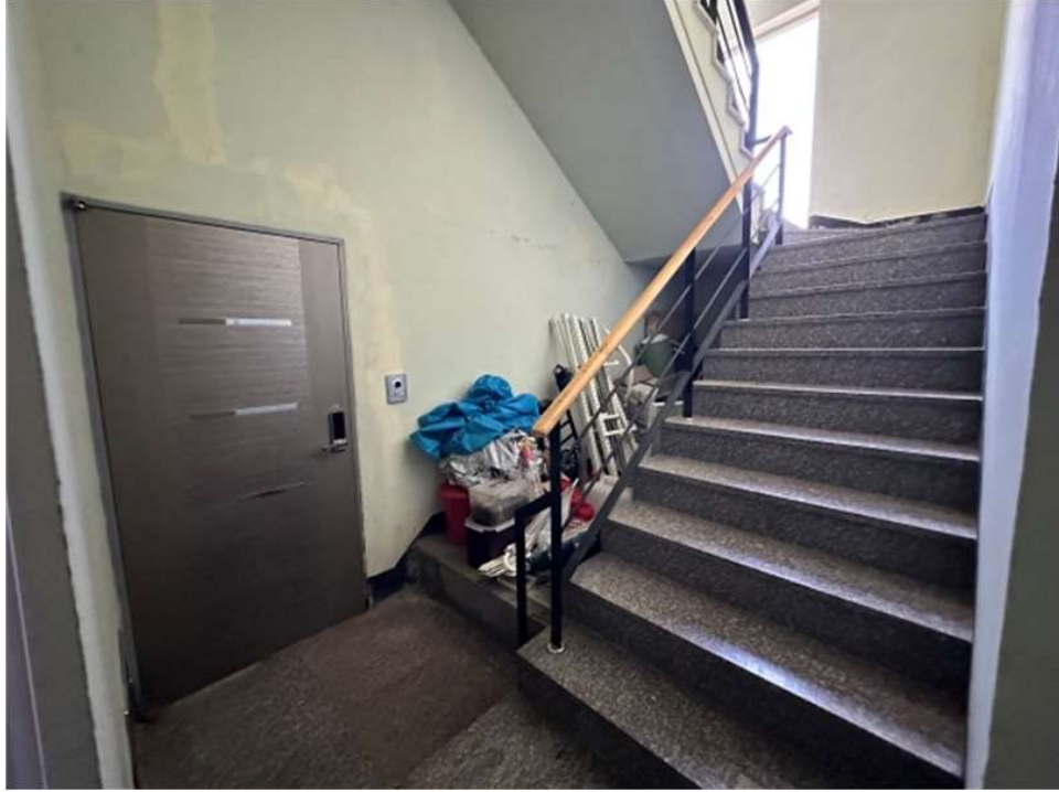
본건 건물 지층 복도 전경
