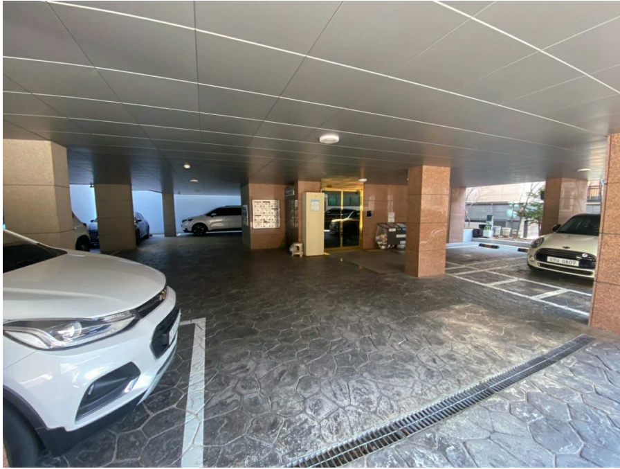
본건 건물 1층 전경
