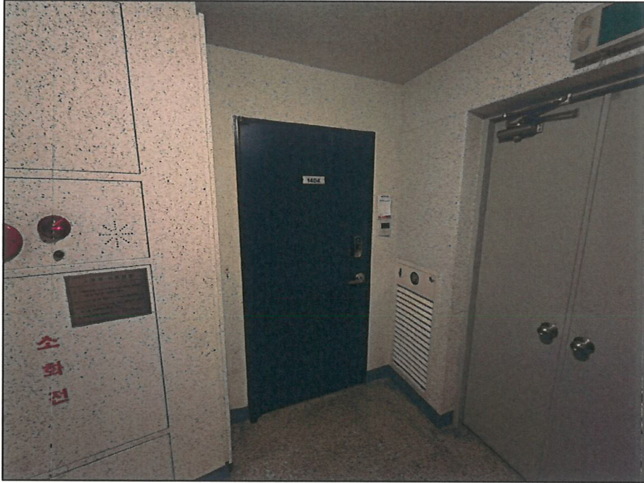
본건 복도 전경
