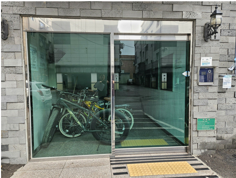
본건 동 1층 출입구
