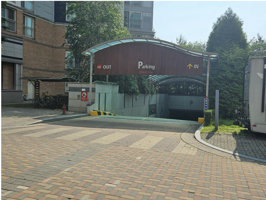
지하 주차장 출입구
