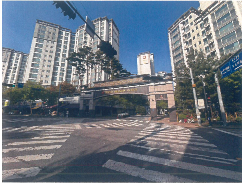
일련번호 (1) 아파트 정문 및 진입도로
