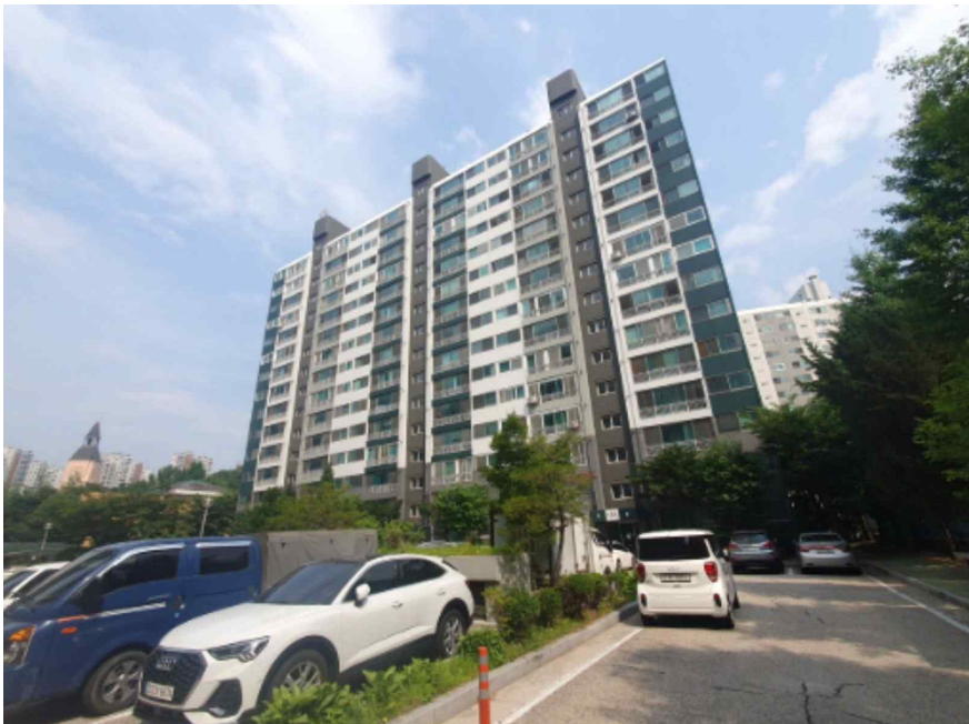
본건전경 - 삼도세라믹아파트 제102동
