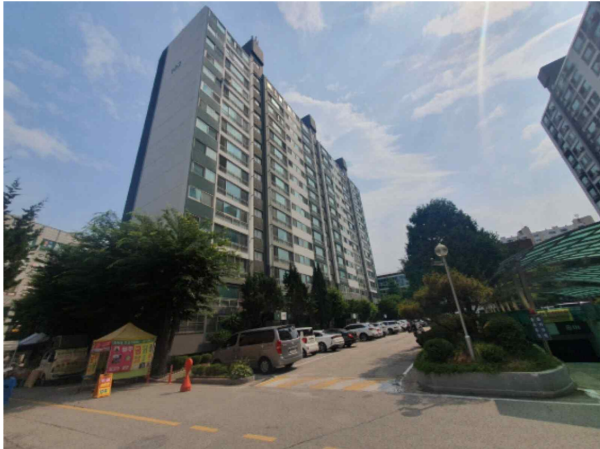
본건전경 - 삼도세라믹아파트 제102동
