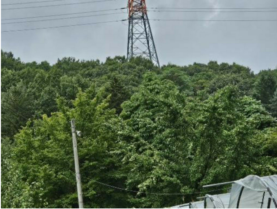
남측 원거리 촬영
