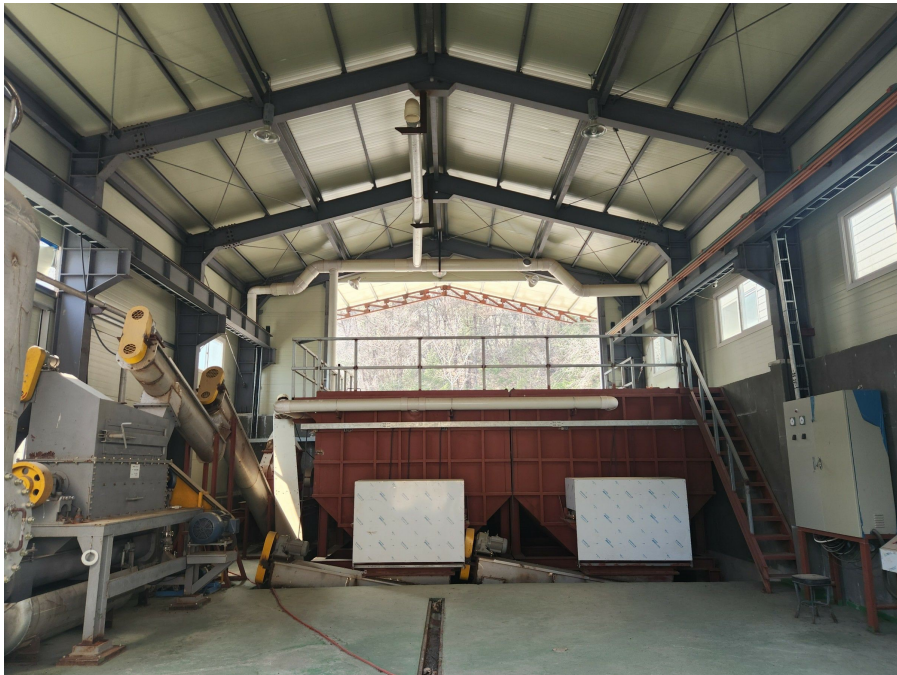
기호 2 건물 내부전경
