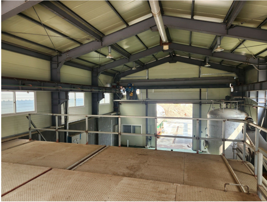
기호 2 건물 내부전경
