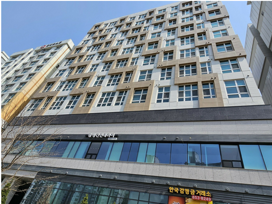
본건 동(민락2지구중흥에스-클래스 트와이스 에이동)
