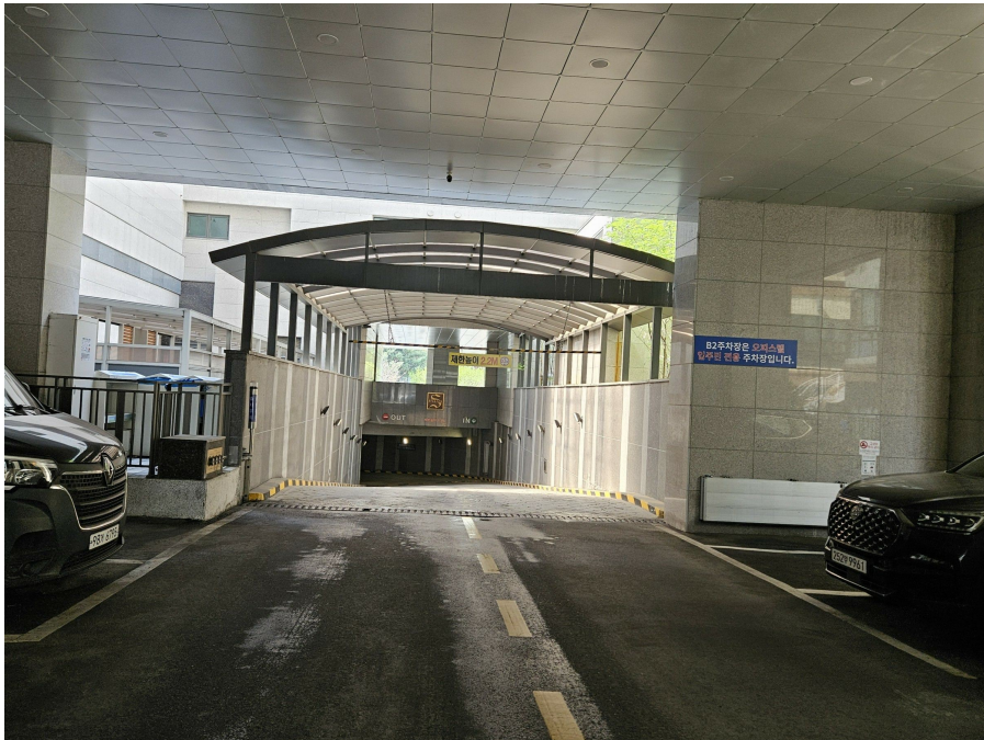
지하 주차장 출입구
