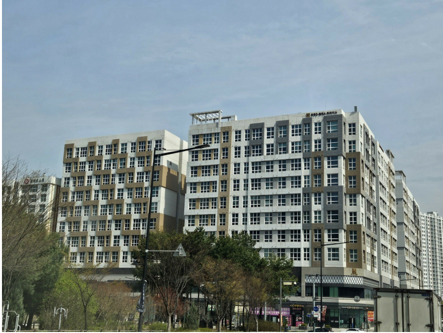
단지 전경(민락2지구중흥에스-클래스 트와이스)
