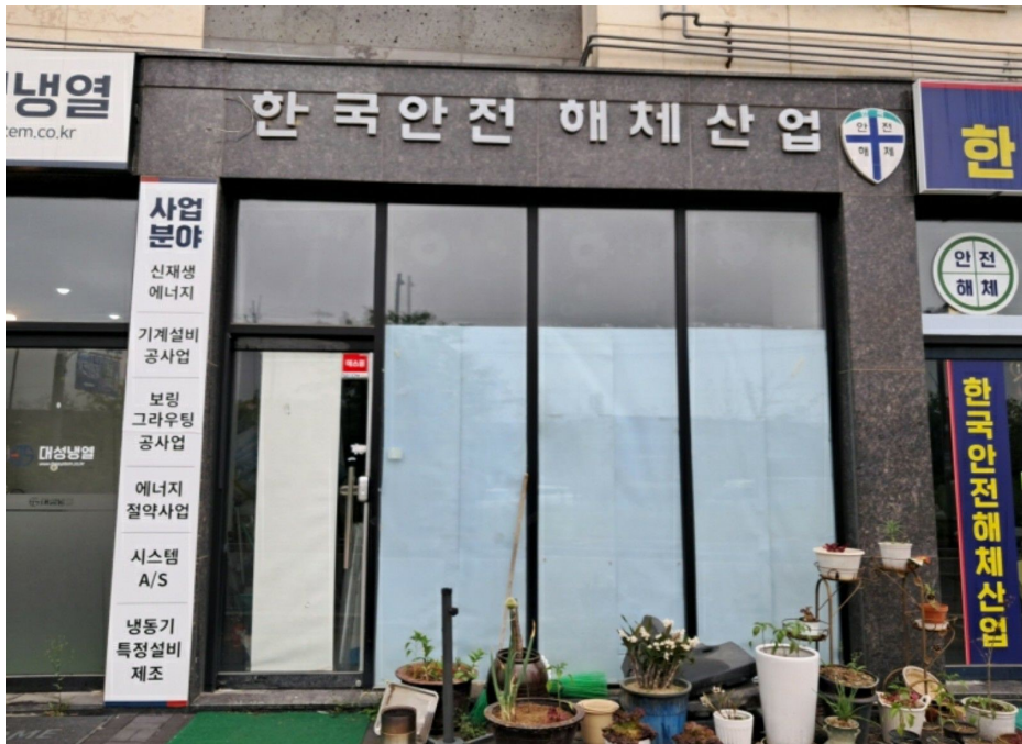
기호(2) 1층 3개호 중 1개호 전경
