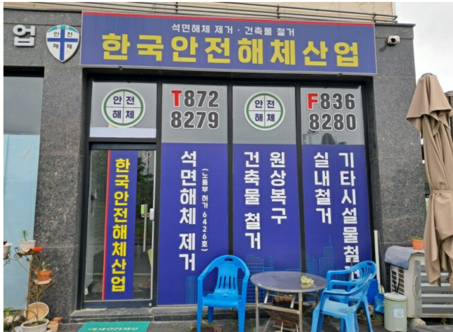
기호(2) 1층 3개호 중 1개호 전경
