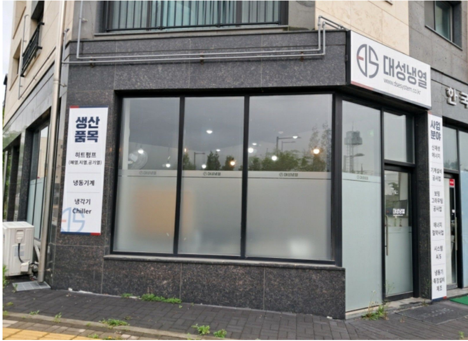
기호(2) 1층 3개호 중 1개호 전경
