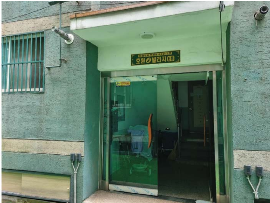
E동 1층 공동출입구 및 계단(서측에서 촬영)
