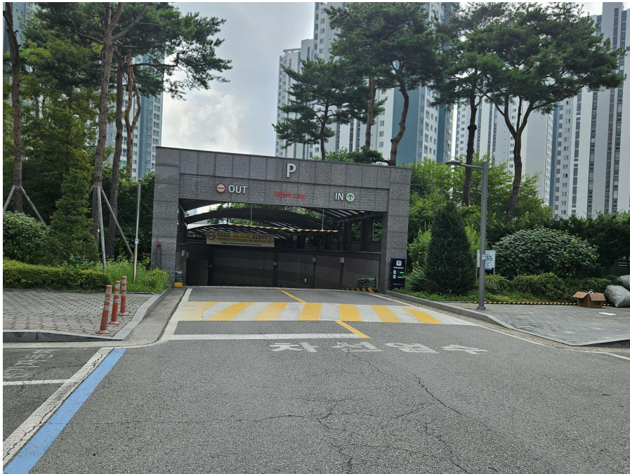
지하 주차장 출입구
