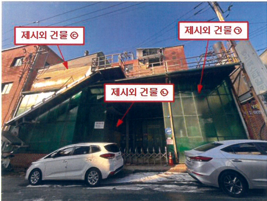
본건 건물 및 제시외건물 전경
