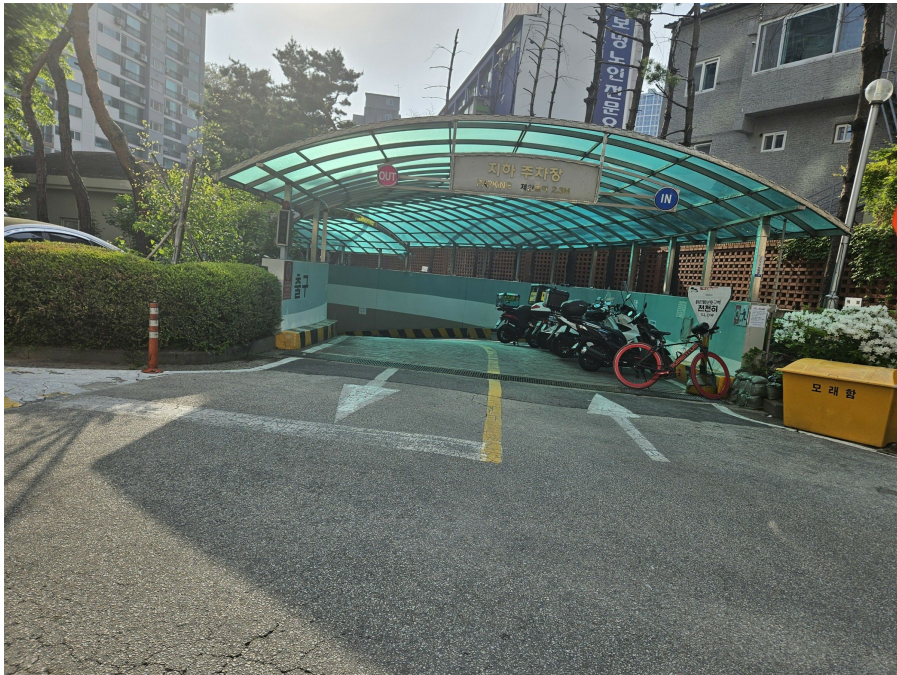
지하 주차장 출입구
