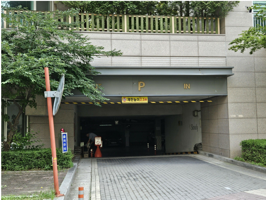
지하 주차장 출입구
