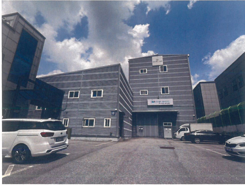
본건 주건물 전경
