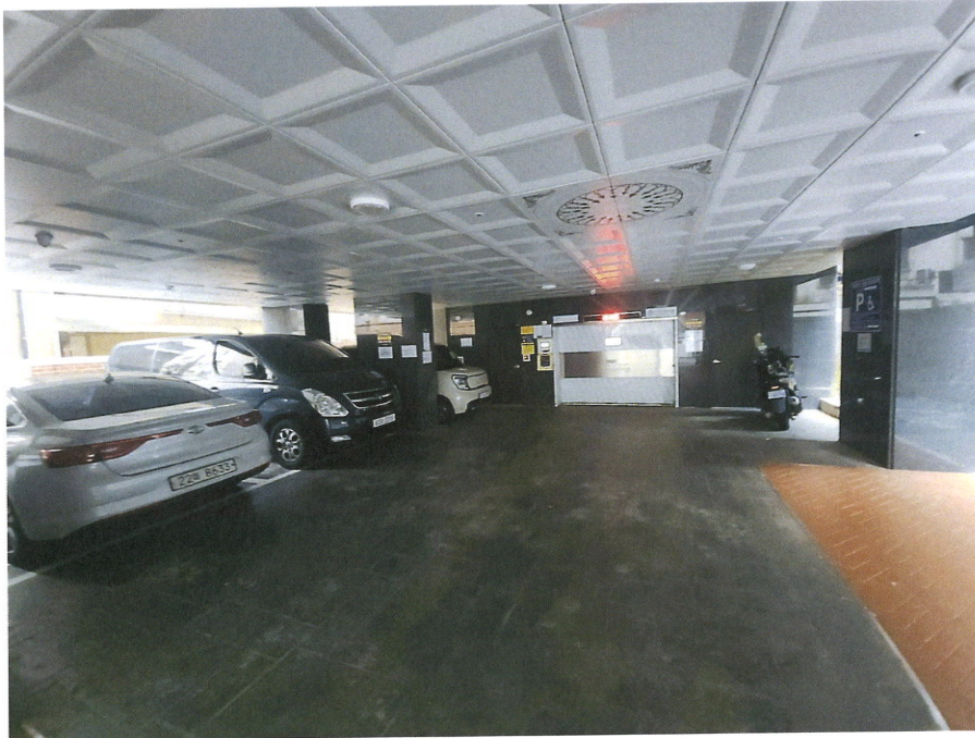
본건동 주차장 및 기계식 주차장 출입구 전경
