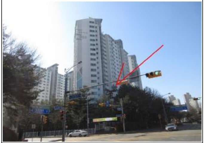
본건전경 (북동측 촬영)
