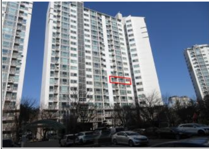
본건전경 (남서측 촬영)
