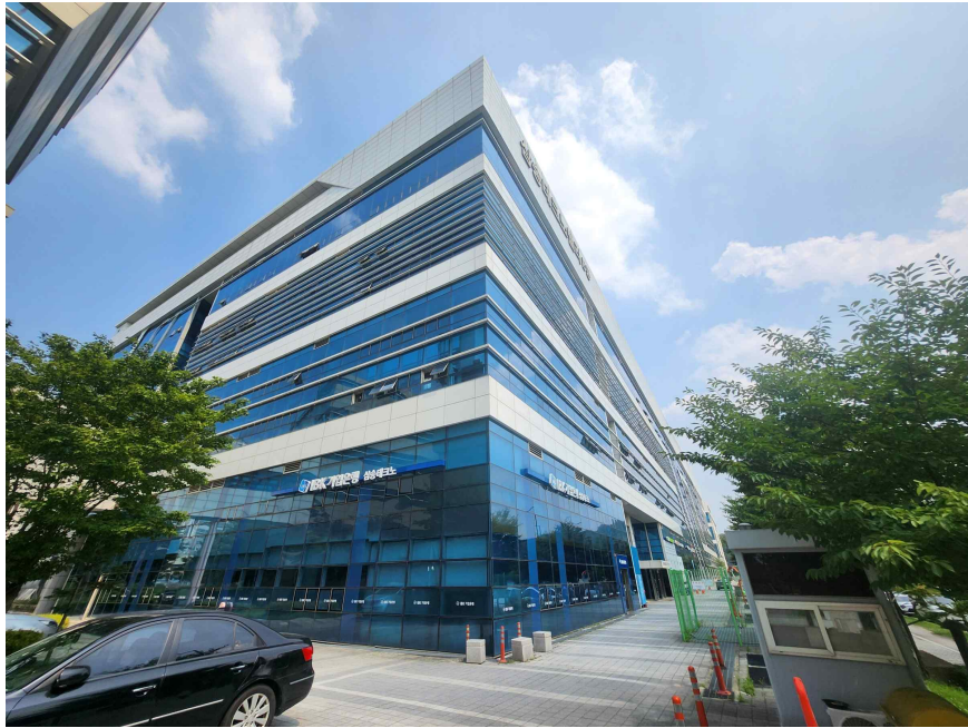
본건 외부 전경
