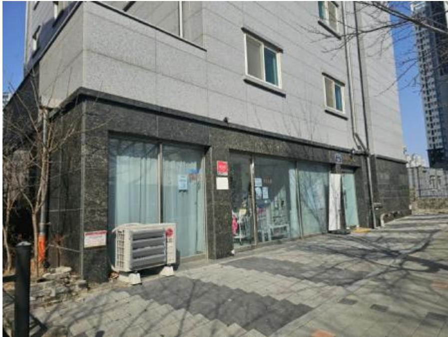
대상물건 (2-가) 전경
