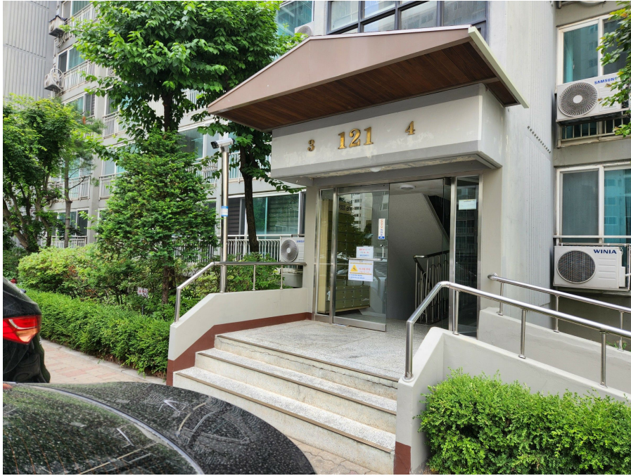
본건 공동 출입구
