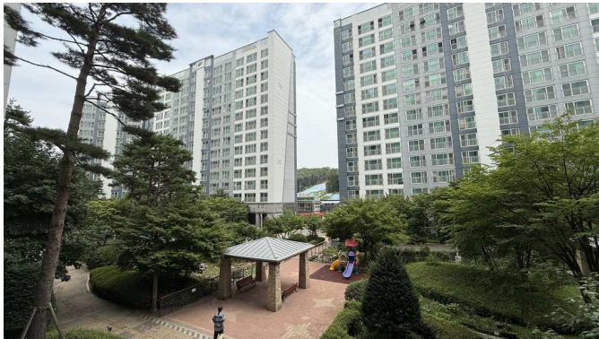
본건 단지내 전경
