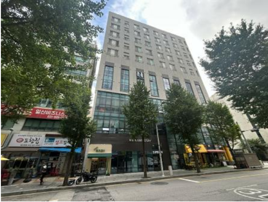
대상물건 건물 남서측 전경
