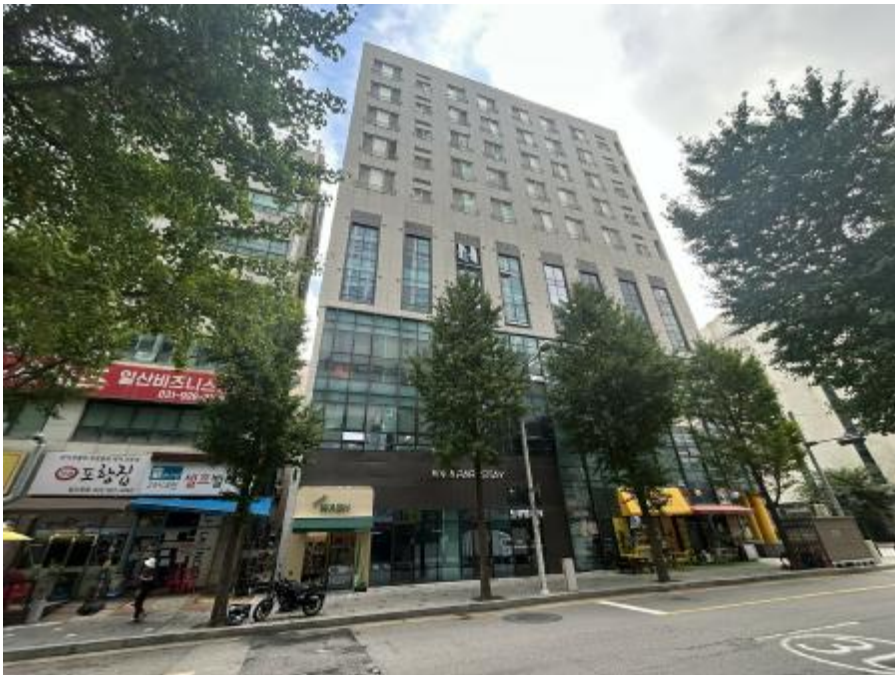
대상물건 건물 남측 전경
