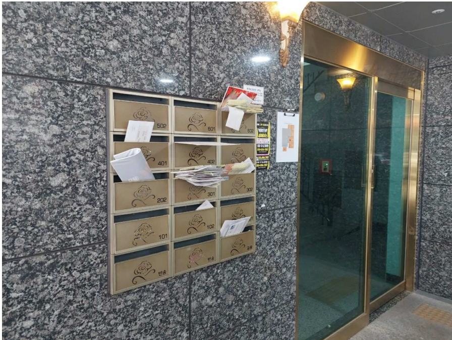
본건 1층 공동출입구 현황
