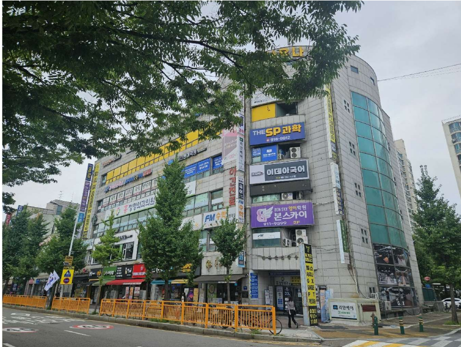
본건 전경 (남동측에서 촬영)
