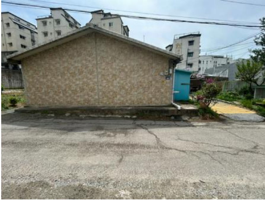
대상물건 2-가 건물 전경
