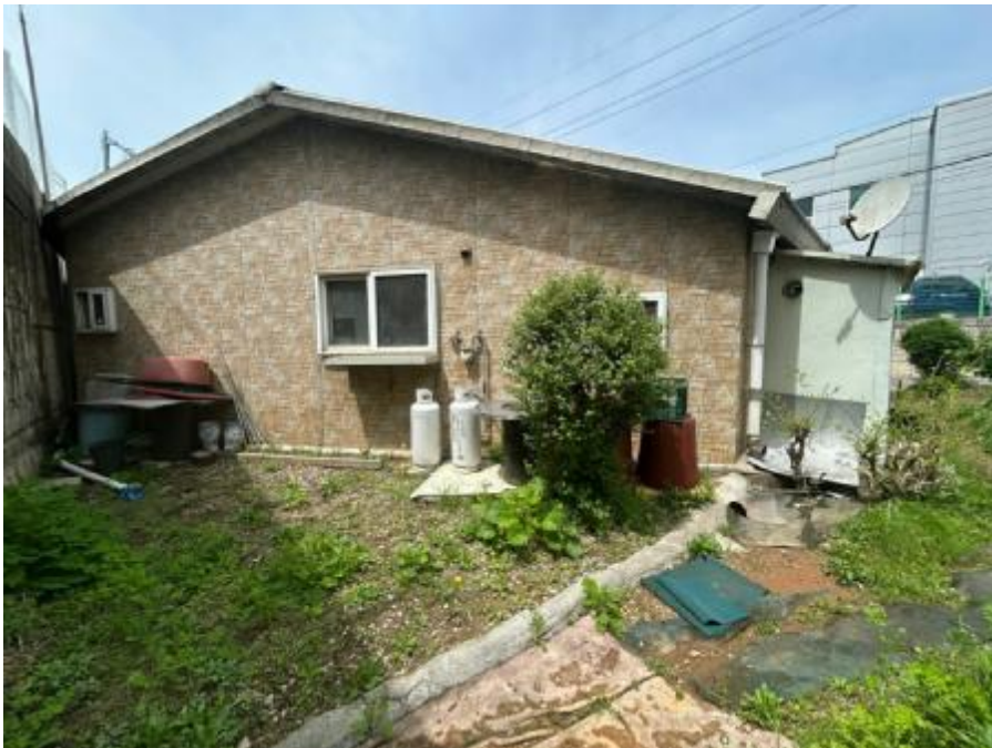
대상물건 2-가 건물 전경
