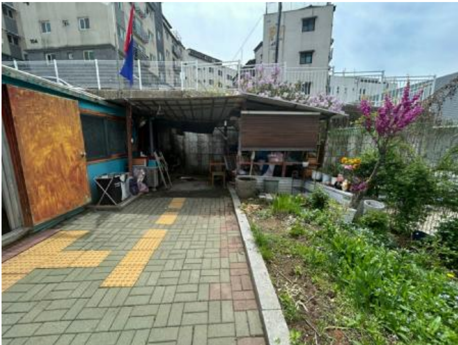
제시 외 건물(인접필지 동패동 2-6번지 지상소재)
