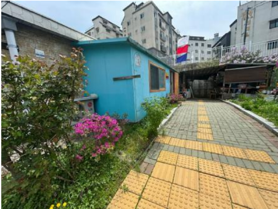
제시 외 건물 ㉠ 전경
