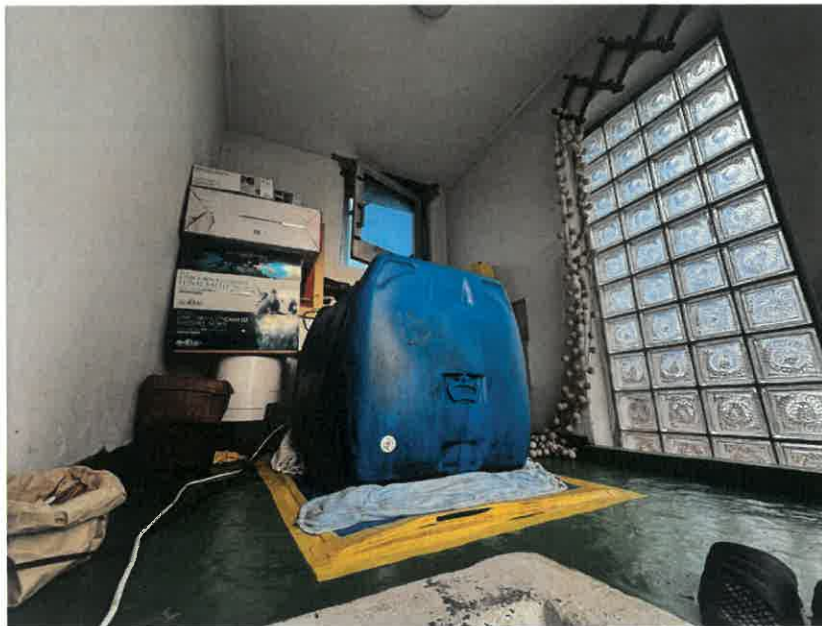
옥탑 내부 전경
