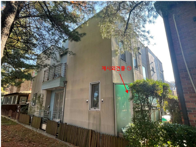
본건 전경 및 제시외건물㉠
